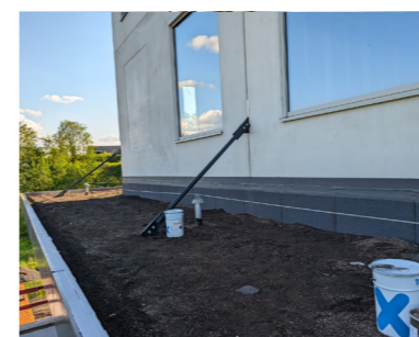
Joints d'étanchéité de toiture Divese
