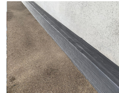
Scellements de détails divers
